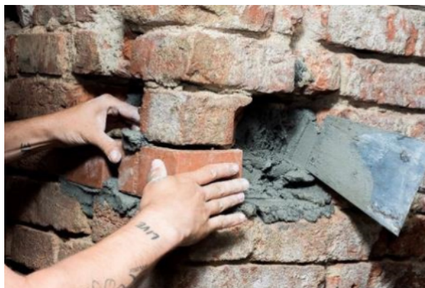
Obr. 3 Založení spodní řady
