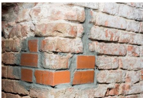
Obr. 5 Zazděný otvor
