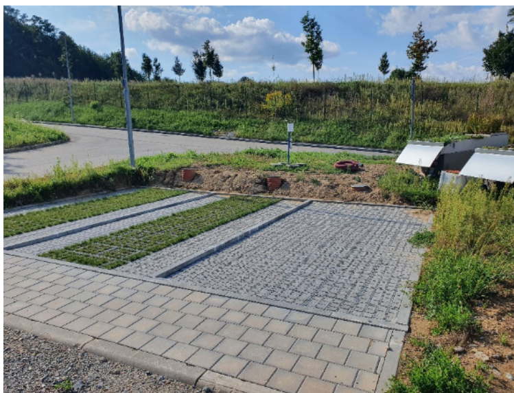
Kompletně dokončené plně instrumentované experimentální zelené parkoviště v centru AdMaS
