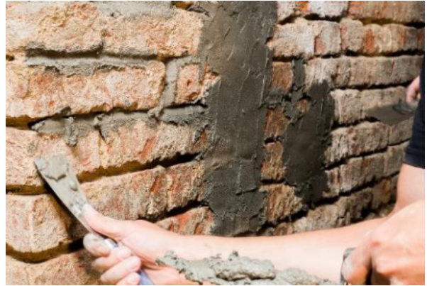
Obr. 8 Spárování zdiva
