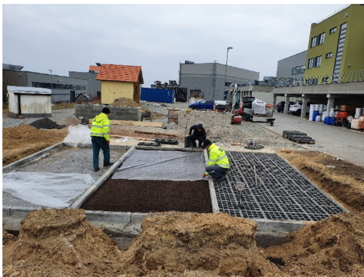
Instalace AS – TTE zasakovacích roštů
