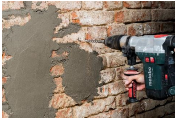
Obr. 10 Příprava otvorů na parky
