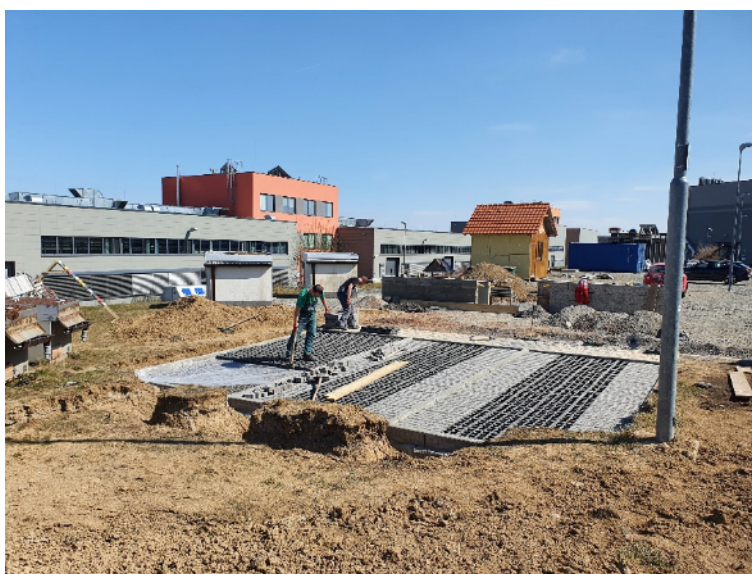
Vkládání betonových výplňových kostek; příprava pro osazení trávniku
