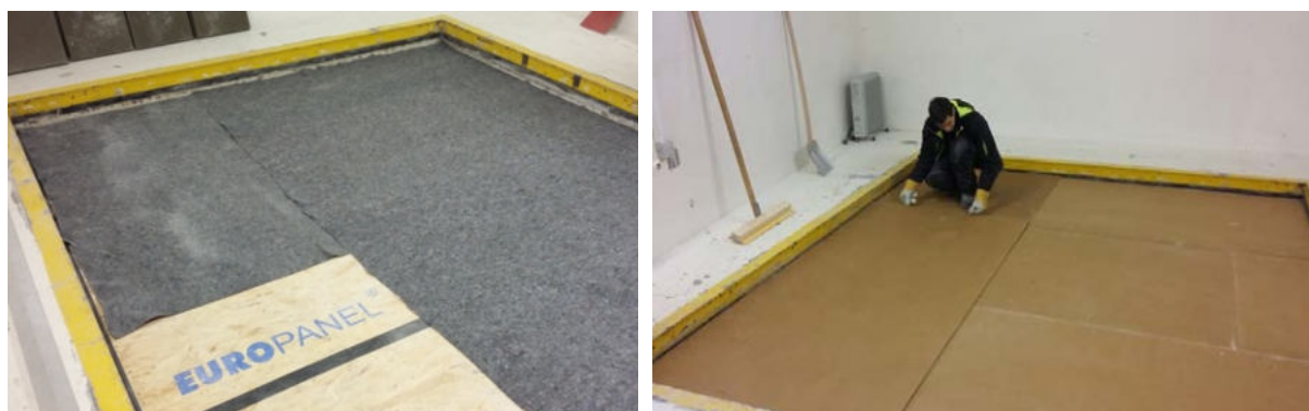
Obr. č. 19: Měření kročejové neprůzvučnosti vybrané skladby podlahové konstrukce
