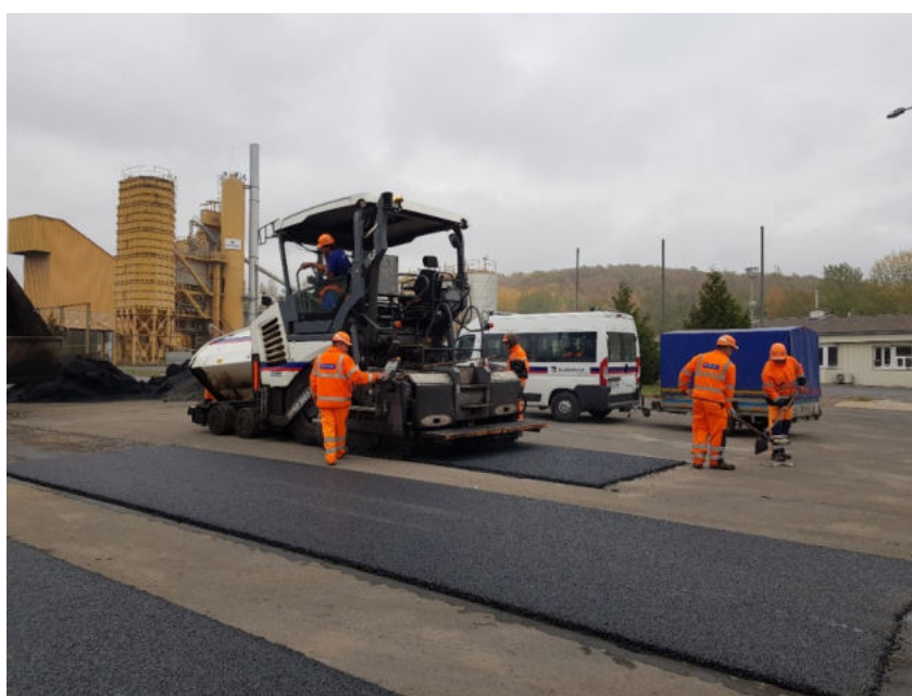
Obr. č. 16: Fotografie pokládky pokusných povrchů z vyvinutých materiálů
