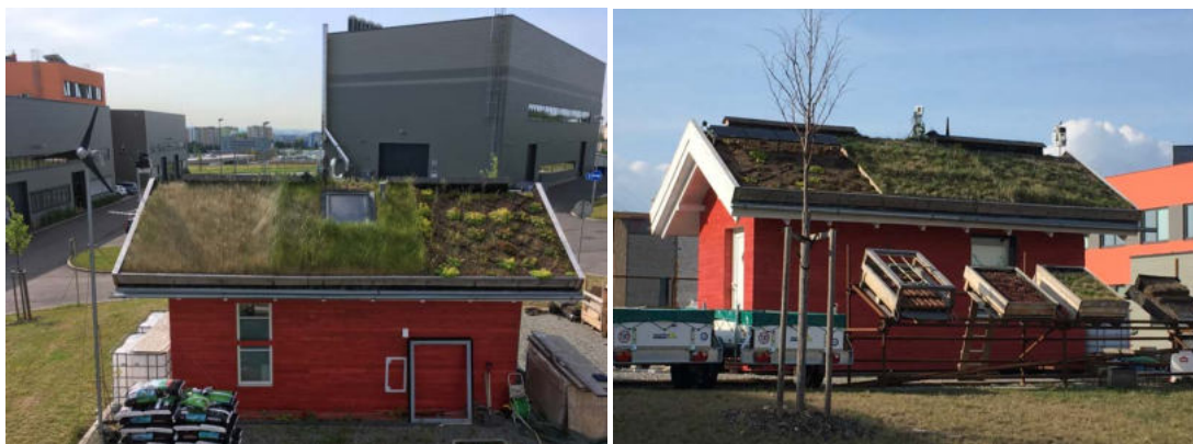
Obr. č. 17: Fotografie experimentálního objektu Envihut
